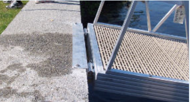
ANGLE DE DÉPART PERMET DE FIXER UNE PASSERELLE À UNE STRUCTURE.
